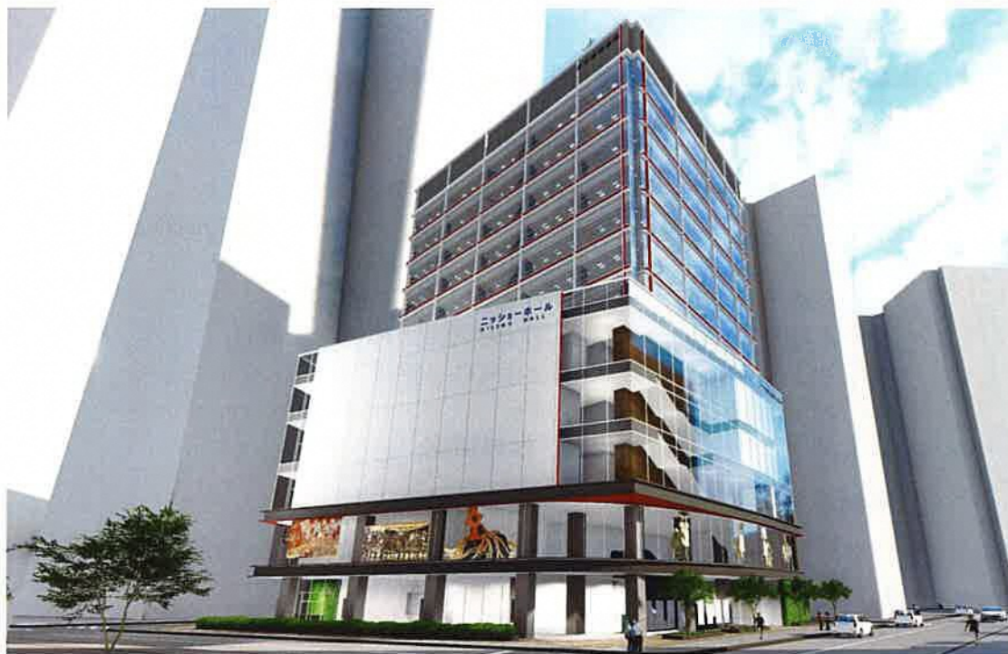
銀座線虎ノ門駅方面より（区道1009、127号線交差点地点）
